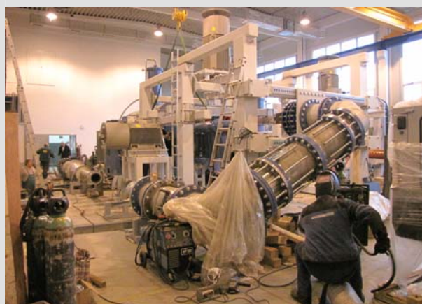
Foto z druhé etapy výstavby hydraulické laboratoře – druhé měřicí stanice.
