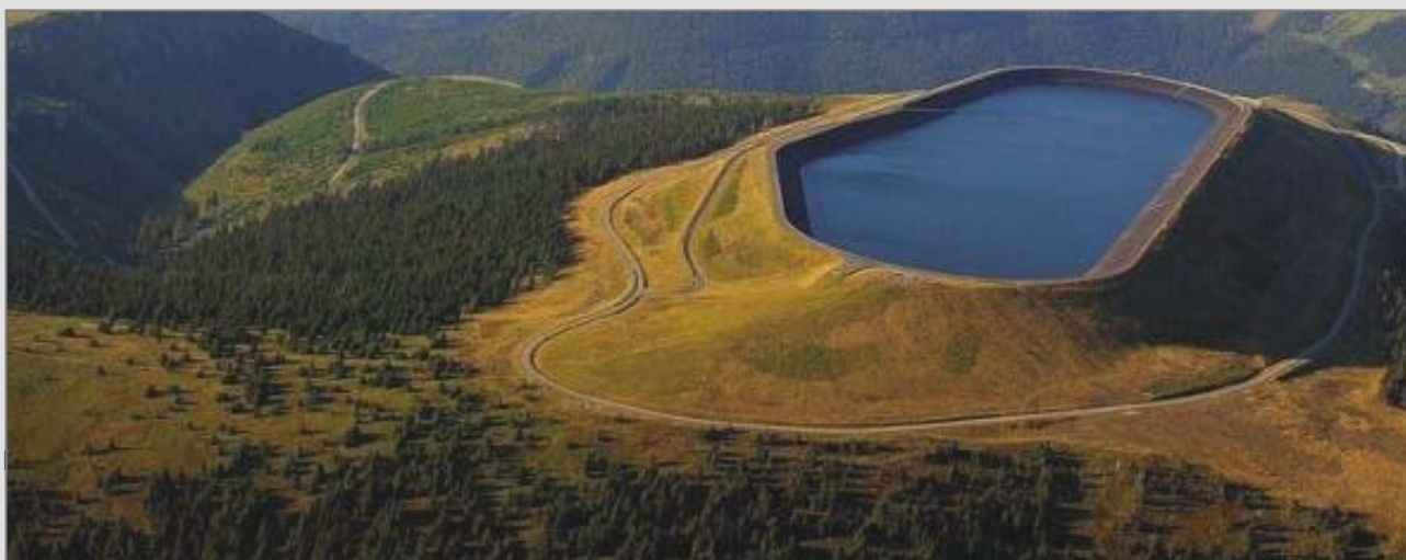
Pohled na horní nádrž přečerpávací vodní elektrárny Dlouhé Stráně
