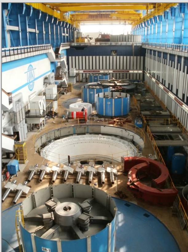
Rekonstrukce PVE Žarnowiec
