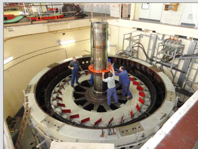
Demontáž soustrojí TG3
