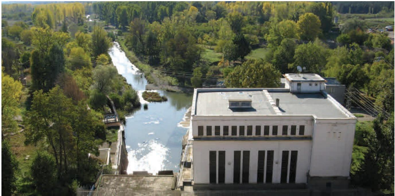
Společnost ČKD Blansko Engineering uzavřela v lednu 2016 kontrakt s Energo-Pro Bulharsko na modernizaci vodní elektrárny Koprinka v Bulharsku s vertikální Kaplanovou turbínou. Nové oběžné kolo bylo navrženo jako šestilopatové o průměru 2150 mm. Maximální výkon na spojce bude po rekonstrukci 9 MW.
