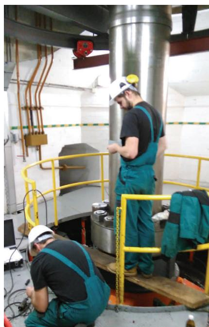
a skenováním hydraulického profilu stávajícího oběžného kola.
