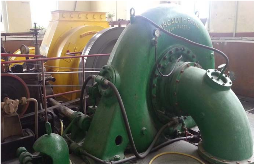
Původní turbína pro VE Klisura vyrobená v Itálii v roce 1950.
