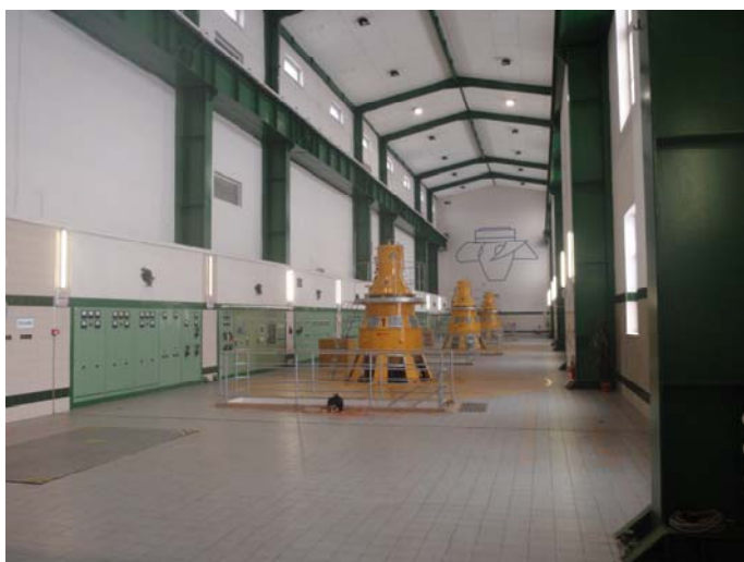
Pohled do strojovny
