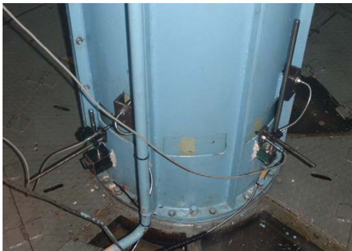
Snímače relativních vibrací hřídele ve vodícím ložisku turbíny
