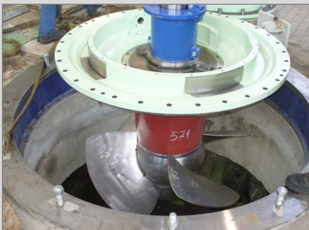
Oběžné kolo s hřídelem turbíny
