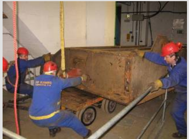
5. Přesun 1/2 tabule pod hlavní jeřáb ve strojovně
