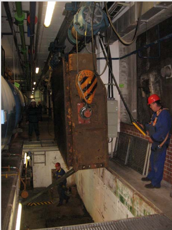
4. Vyzvednutí pootočené 1/2 tabule na podlahu ovládání klapky
