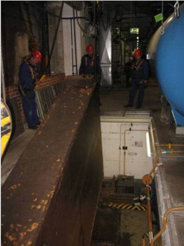
4. Vyzvednutí pootočené 1/2 tabule na podlahu ovládání klapky
