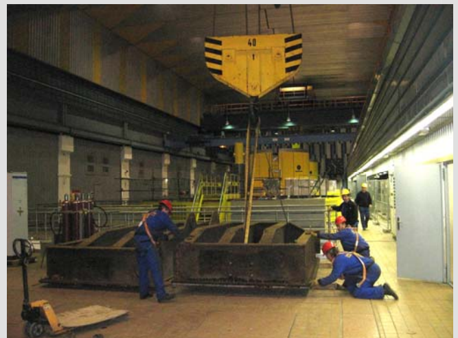
7. Uložení 1/2 tabule na podlahu strojovny
