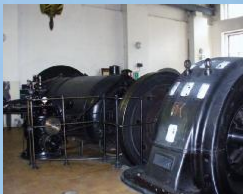
Strojovna s původní turbínou a generátorem
